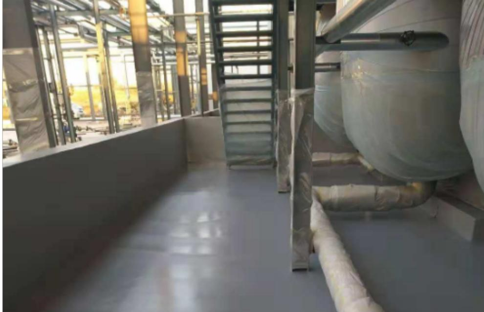
聚脲是由异氰酸酯组份与氨基化合物组份反应生成的一种弹性体物质。分为纯聚脲和半聚脲，他们的性能都是不一样的，聚脲的基本的特性就是防腐、防水、耐磨等。百度的解释是：聚脲是异氰酸酯组份和氨基化合物组份反应生成的一种弹性体物质，也叫聚脲弹性体。聚脲分为纯聚脲和半聚脲，性能不同，聚脲基本的特性是防腐，防水，耐磨，抗冲击，抗老化性能优越。聚脲的特点：不含催化剂无挥发，快速凝固，可在任意曲面，斜面，平面及垂直面上喷涂成型，而且不产生流挂现象，10秒钟左右初凝，1分钟就可以上人行走。对温度和湿度不敏感，可以在-28°条件下施工，就算在冰面上都可以喷涂固化。聚脲为双组分反应材料，100%固化，无挥发，不污染，对环境友好，属于环保材料。厉害的理化性能，极高的抗张以及抗冲击强度，柔韧性，耐磨性，耐老化，防湿滑，防腐蚀。稳定性能优越，可在120°一下长期使用，并且能够承受350°的短期热冲击。基础原型保持良好，无接缝，整体施工，涂层连续，致密，美观实用。良好的粘结力，可以在混凝土，钢结构，木材等众多材料上使用。
